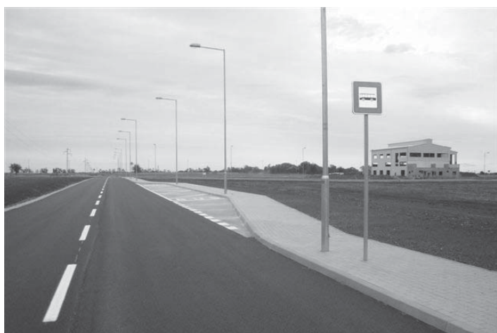
Priemyselný park je vybudovaný, v súčasnosti prebieha kolaudácia jednotlivých stavieb a prví investori, s ktorými sú podpísané nájomné zmluvy môžu realizovať výstavbu svojich prevádzok.
