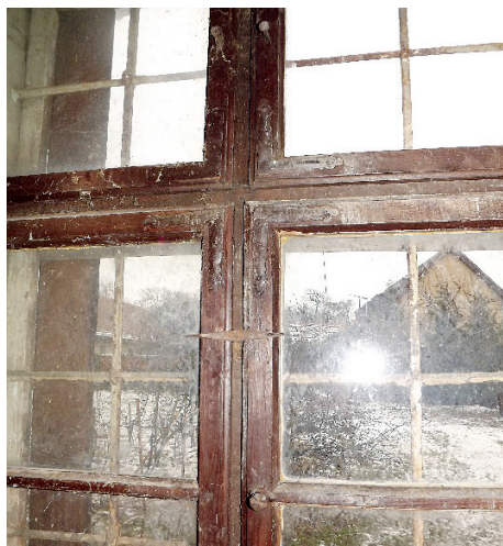
Detail zachovaného barokového okna z 18. storočia s kovými prvkami v priestore dnešnej kotolne
