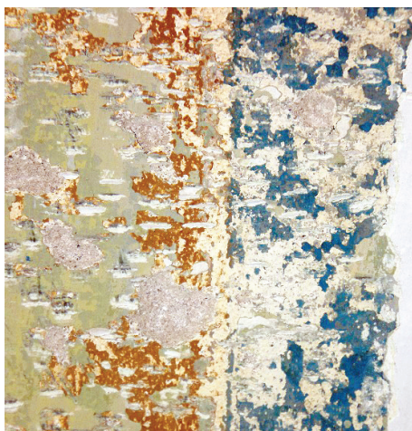
výzdoba strednej izby v starej časti východného krídla (podobný spôsob členenia stien a aj zachovaná lazuúra na spôsob mramorovania na modrom podklade)
