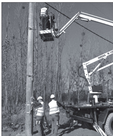
Ilustračná snímka z rekonštrukcie NN siete
