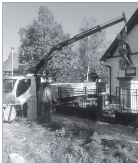
Demontáž zubom času poškodenej sochy sv. Floriána
